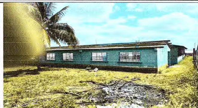
Foto 2: Mantenimiento de estructuras metálicas Módulo I
