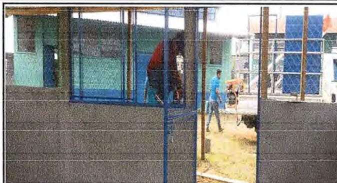
Foto 2: Colocación de puertas, ventanas y malla de la cocina del establecimiento educativo.
