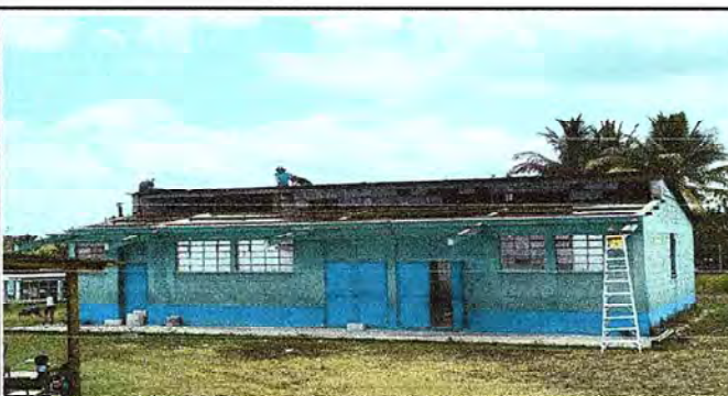
Foto 4: Mantenimiento de estructuras metálicas del módulo II
