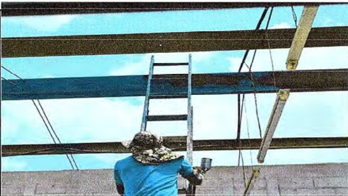
Foto 3: Lijado y pintado de estructuras metálicas del Módulo I
