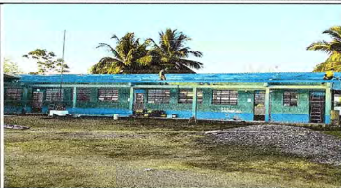
Foto1: Inicio cubierta de lámina, módulo I
