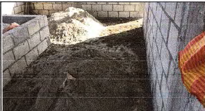
Foto 1: Preparación de material para el piso de la cocina del establecimiento educativo.
