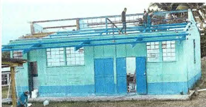
Foto 5: Instalación de Base de Vidrio Metálica del Módulo II
